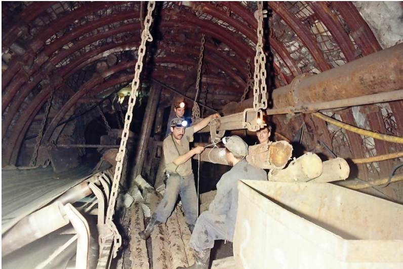
Galerie de transport, cu bandă transportoare și pentru transportul materialului lemnos
