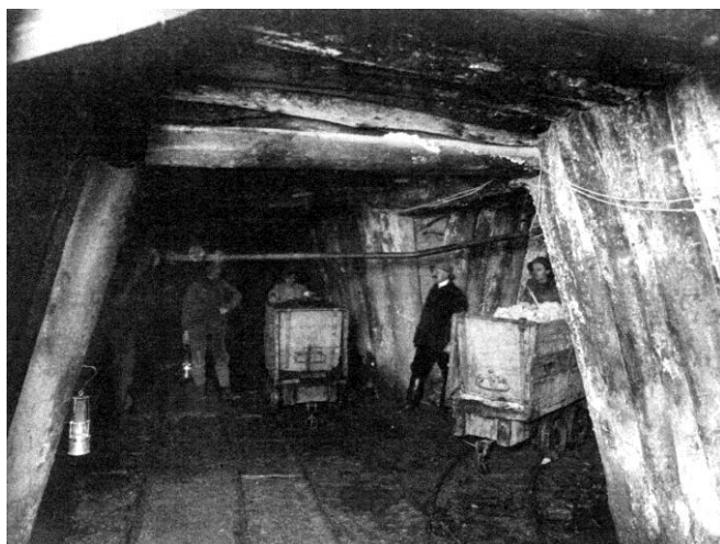
Galerie principală de transport în subteranul minei Deak
