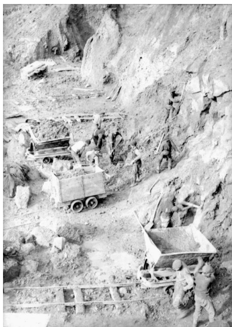
Exploatarea la zi al aflorimentului stratului principal nr.3.
