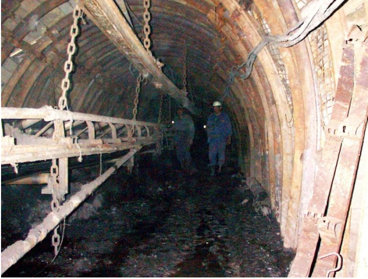
Galerie principală de transport cu bandă transportoare de cauciuc
